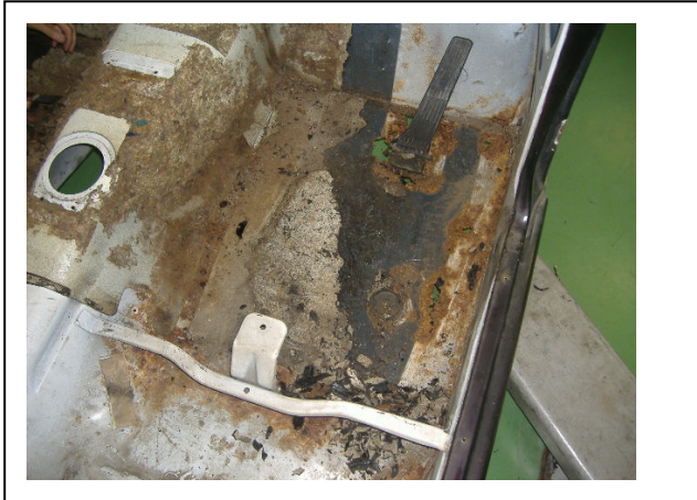
元の床の状態。
