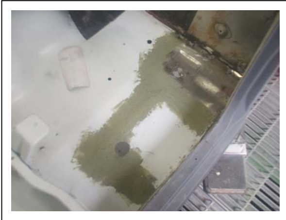
溶接後パテ整形。
