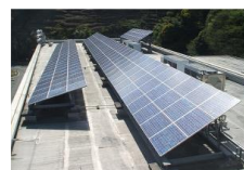
最大出力30Kwhのソーラーパネル
