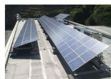
最大出力30Kwhのソーラーパネル
